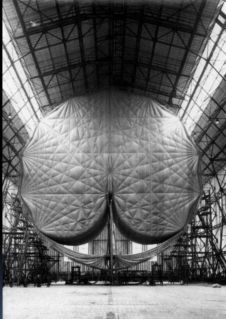
Collaudo di una cella . Le singole celle venivano collaudate in una struttura apposita, in pratica una sezione del dirigibile. Si può notare l'intreccio dei cavi di irrigidimento della struttura.
