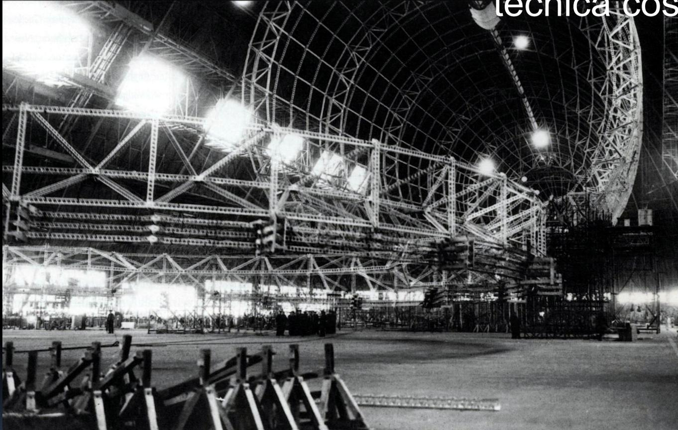
Anno 1930. Nell'Akron, e poi nel Macon, progettati per conto dell'US Navy, cambia la struttura delle ordinate principali, non più a triangoli singoli, ma a trave continua a sezione triangolare spaziale. Analoga struttura viene usata per tre chiglie longitudinali, mentre viene eliminata la trave centrale usata fino allora.
