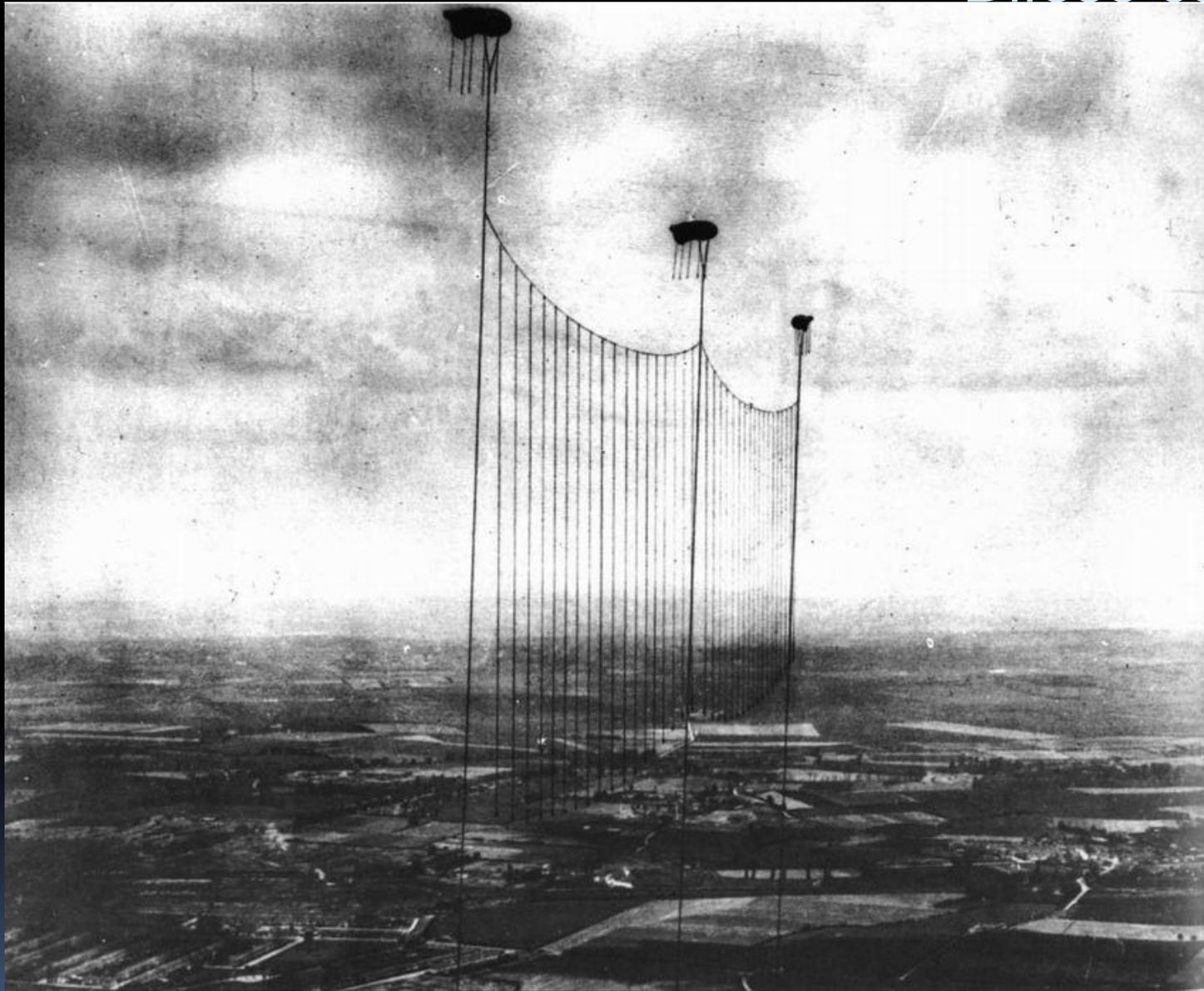
Per proteggere le città dalle incursioni degli Zeppelin furono usate barriere di cavi sostenute da palloni frenati. Non ebbero risultati di rilievo
