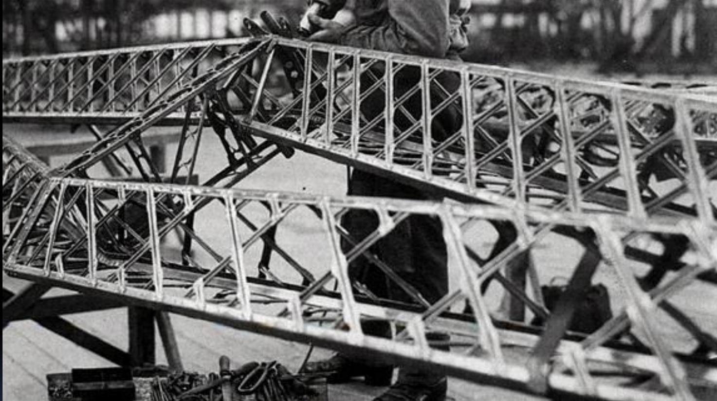
Anno 1926. Particolare di trave dell'LZ 127 o 129 : la struttura base a omega è la stessa , ma gli elementi sono stati infittiti nella parte esterna del triangolo, sottoposta a compressione, mentre nella parte interna, sottoposta a trazione, gli elementi sono più radi e sono stati introdotti dei rompitratta.
