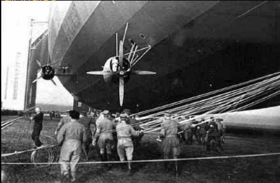
Operazioni di ormeggio subito dopo l'atterraggio. Il meccanico in tuta bianca in piedi accanto all'elica e i componenti l'equipaggio sulla passerella del motore anteriore permettono di apprezzare le dimensioni del dirigibile.
